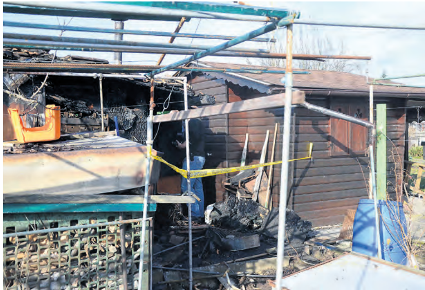
Familiengarten «Hörnli». Das Feuer brach in einem Ofen im hinteren Bereich des Hauses aus und führte zu grossem Schaden am Gebäude. Foto Mischa Hauswirth
